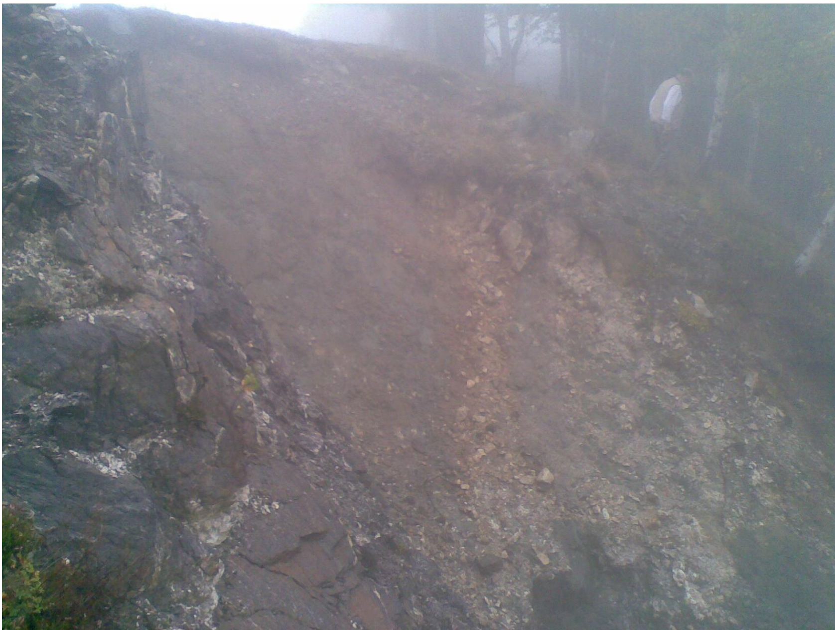
Superficie di scivolamento in prossimità del coronamento
